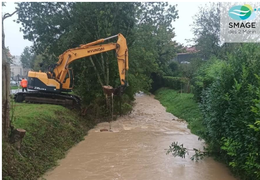
Figure 39 : Travaux d'extraction de sédiments sur le ru des Cordelins à la Ferté-Gaucher - 09/10/2024
