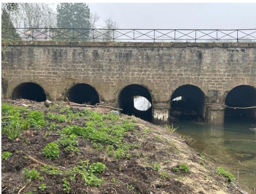
*Accumulation de sédiments et de terres au niveau de l'ouvrage - 26/03/2025*
