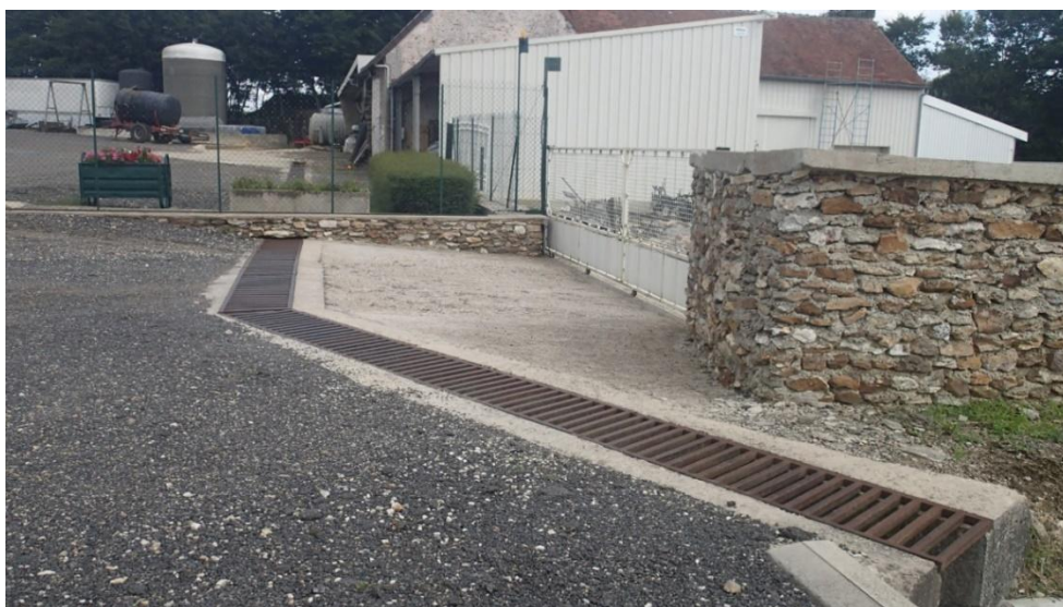
Figure 19 : Cunette traversant la ferme le long de la RD46 et qui transite les écoulements en provenance des drains agricoles
