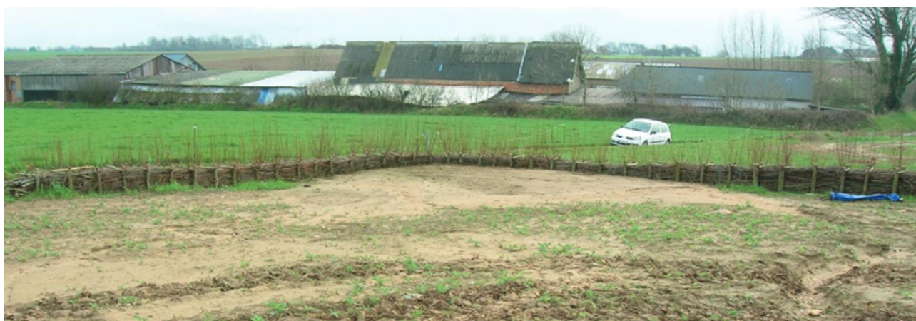
Figure 13 : Schéma explicatif et exemple de fascine (source : AREAS)
