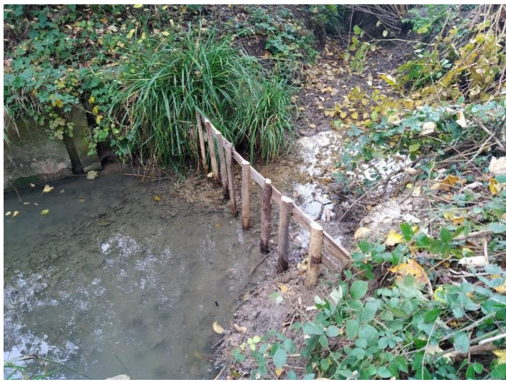
Figure 31 : Photographie du piège à embâcle en amont de la grille du Ru de Lochy ©SMAGE 2 Morin
