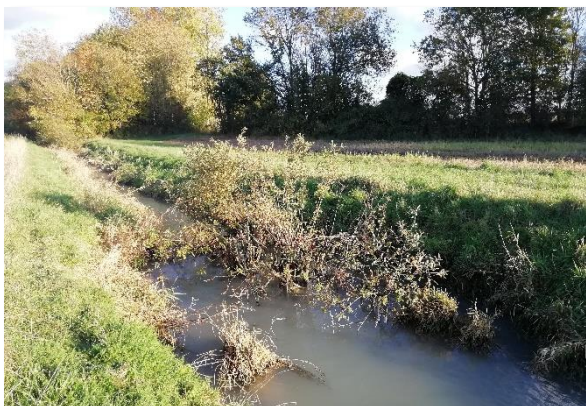
Figure 40 : Entretien de ripisylve inadapté engendrant des problématiques d'écoulement
