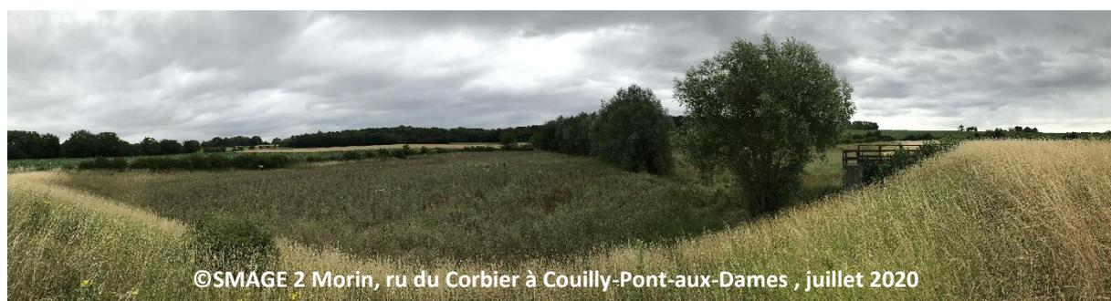
Figure 59. Bassin écrêteur de crue situé sur le ru du Corbier, dimensionné pour une crue centennale
