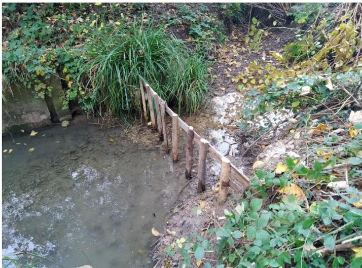
Figure 31 : Photographie du piège à embâcle en amont de la grille du Ru de Lochy
