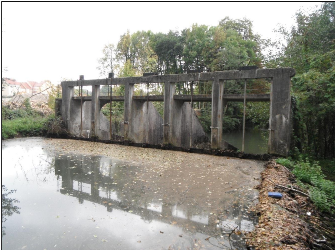
Figure 8 : Vue amont du vannage du moulin du Pont, état actuel (13/10/11)
