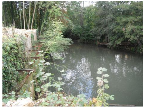
Figure 3 : Muret en rive gauche, à déraser
