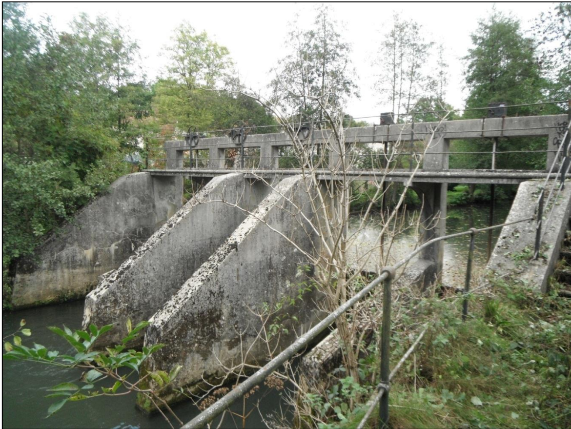
Figure 10 : Vue aval du vannage du moulin du Pont, état actuel (13/10/11)
