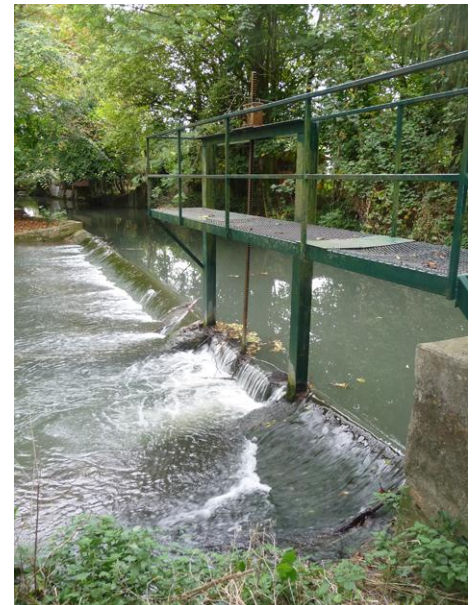
Figure 2 : Vue de l'ouvrage de décharge à araser partiellement, puis à aménager
