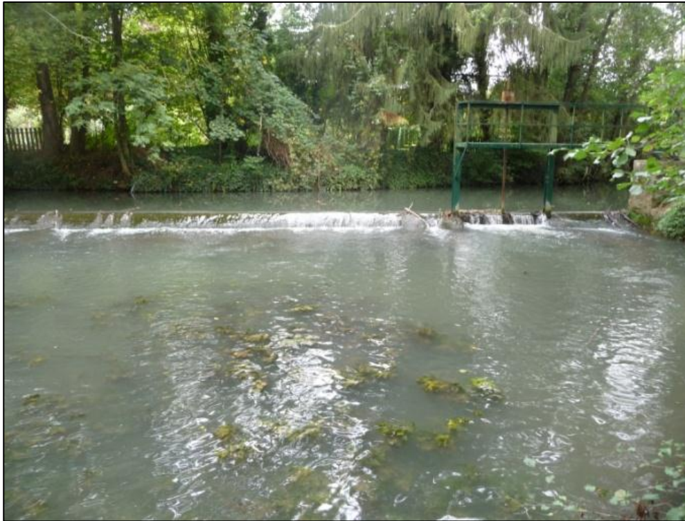
Figure 9 : Vue de l'ouvrage de décharge, état actuel
