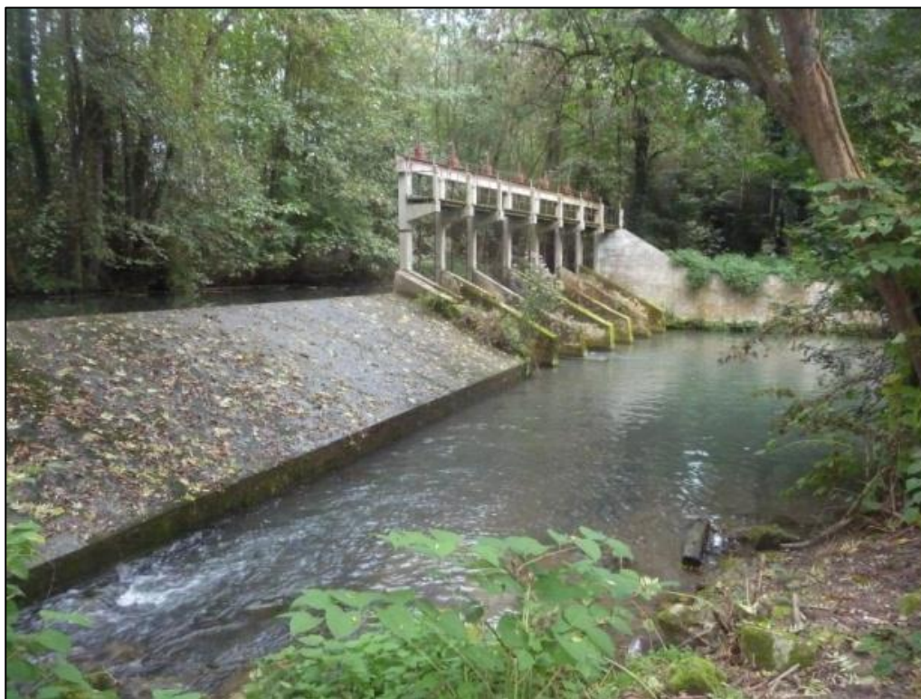
Vue de l'ouvrage, état actuel
