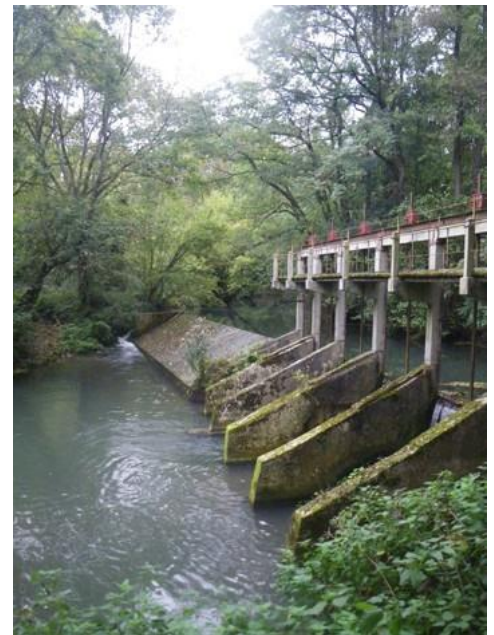
Figure 2 : Vue de l'ouvrage partiteur à dégrader
