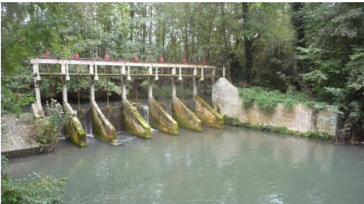
Figure 3 : Vue du bâti à démanteler et déraser
